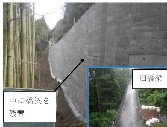
写真-1 施工完了後 (盛土側面)
