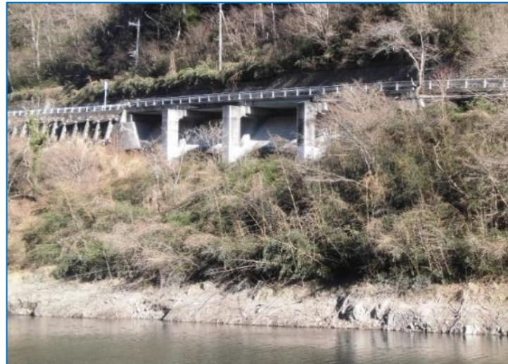
◆急傾斜地の栈道橋など
