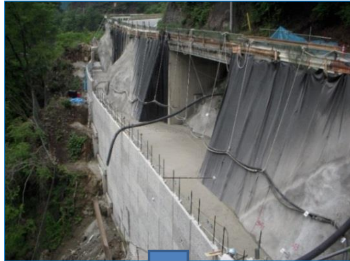
◆栈道橋(エアモルタル)下部充填
